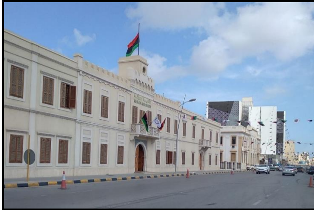
صورة (7): مبنى بلدية مصراتة (القصر الحكومي سابقًا) المصدر: عدسة عائشة عيسى، بتاريخ 2021/02/23.
